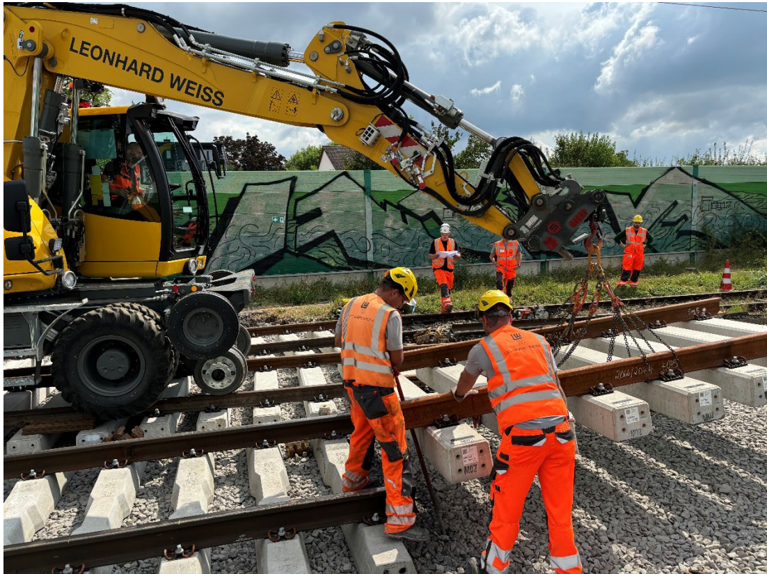
Gleisbauarbeiten auf der Riedbahn im Rahmen der Generalsanierung 2024
